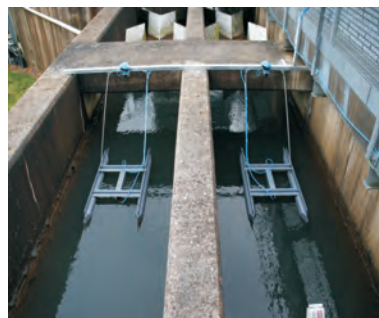
플로팅 센서와 연동 설치된 NivuCompact
