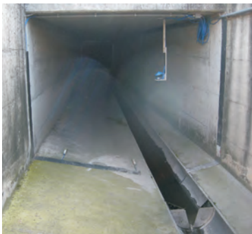
OCM Pro CF와 연동 설치된 NivuCompact
