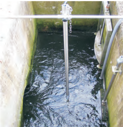
센서 설치 현장
